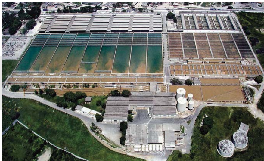
Estação de Tratamento de Água do Guandu - ETAG
