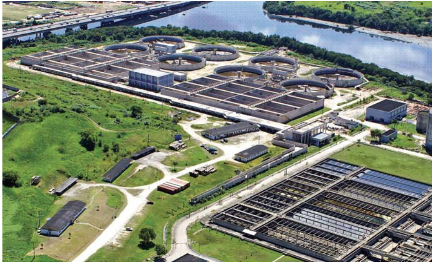
Estação de Tratamento de Esgoto da Alegria - ETE Alegria
