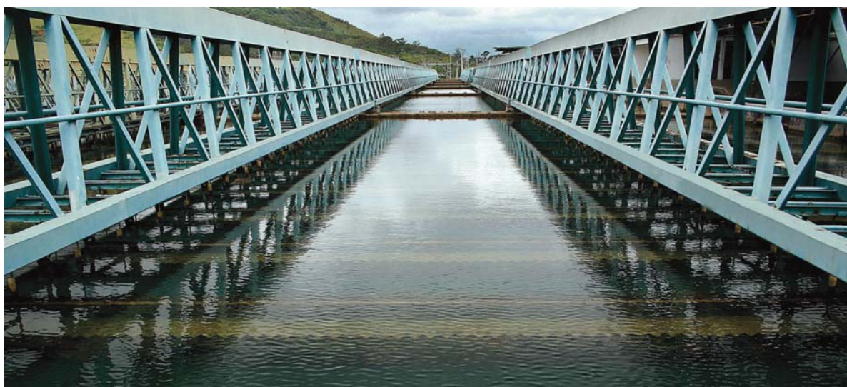
Estação de Tratamento de Água do Guandu - ETAG
